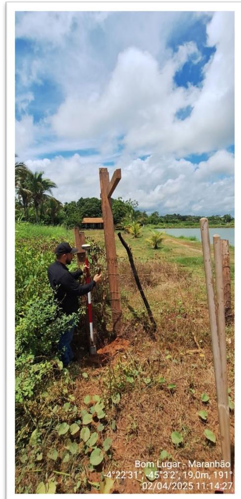
**Fig. 8 e 9:** Medição e implementação de marco físico.
