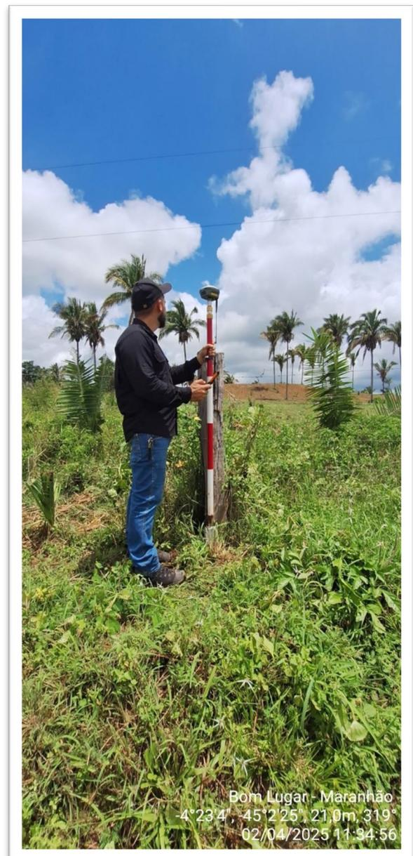
**Fig. 11 e 12:** Medição e implementação de marco físico.
