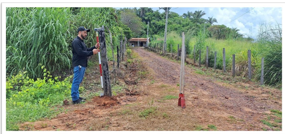
**Fig. 10:** Medição e implementação de marco físico.
